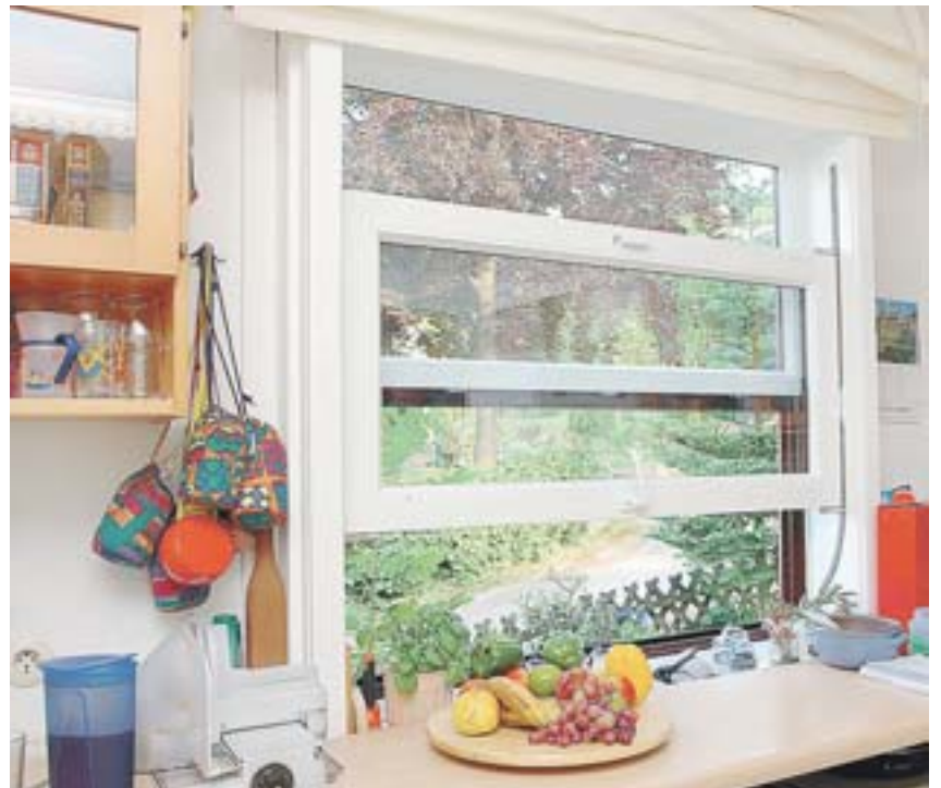
Wenn sich Fenster zum Öffnen stufenlos nach oben schieben lassen, kann kein Flügel im Weg stehen oder zuschlagen und auf der Fensterbank abgestellte Gegenstände herunterwerfen. Foto: Sorpetaler
