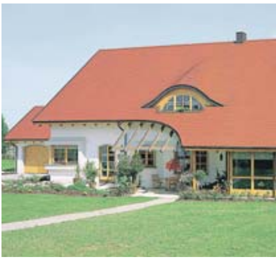
Imposante Fledermausgauben lockern jede Dachfläche auf und ermöglichen eine neue attraktive Form des Wohnens unter dem Dach. Foto: Dach.de/interPress
