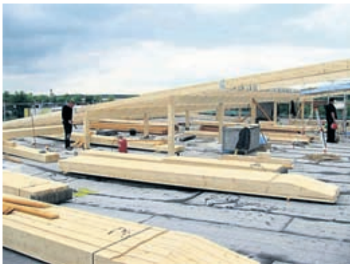
Oben auf dem Dach der Schule hat man einen guten Überblick.
